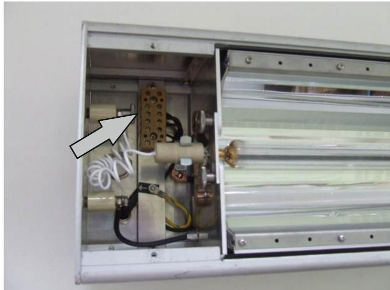
7. Lösen Sie die Rändelmutter der Sicherungsbügel und klappen Sie diesen weg.
